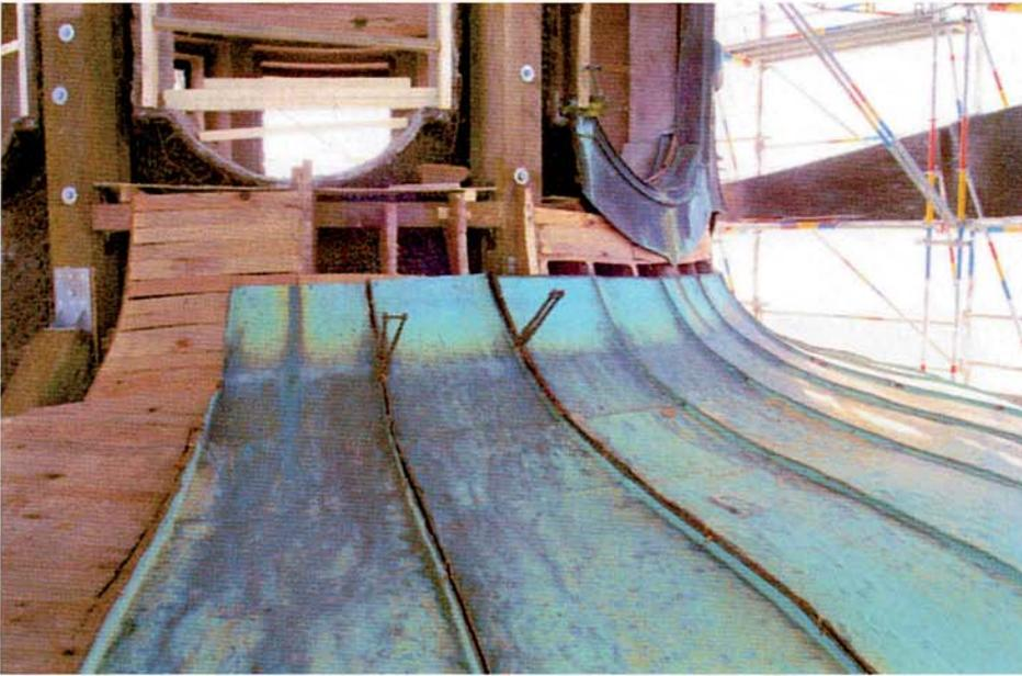
Die zwischenzeitlich eingelagerten Kupferscharen werden auf der neuen Schalung angepasst.
