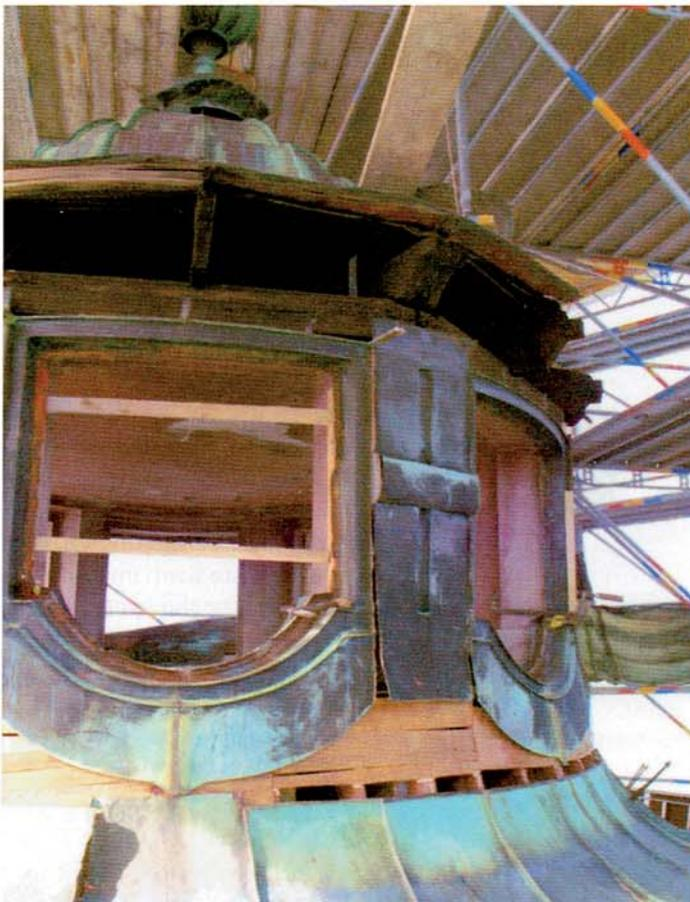
Am oberen Scharenende wird ein Belüftungsschlitz gelassen, um künftig Kondensatbildung zu vermeiden.
