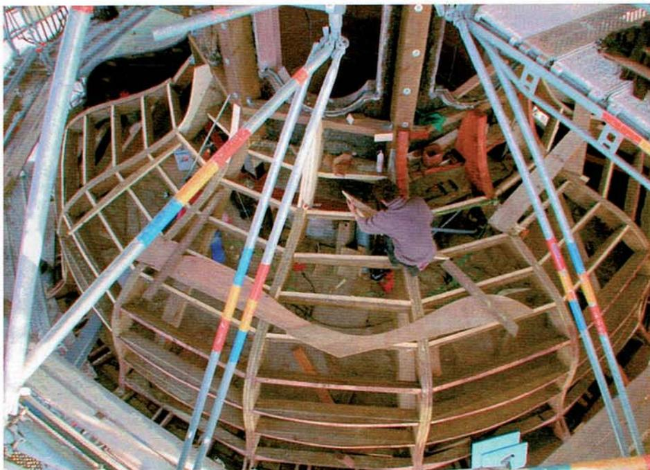
Das Tragwerk der Kuppel wurde in zwei Abschnitten rekonstruiert. Während die eine Hälfte noch abgedeckt ist, werden in der anderen Hälfte bereits neue Profilsantenn eingebaut.
